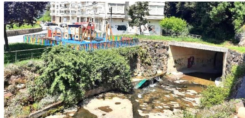
Foto 4.1 Artigas Arroa, en el punto donde se une un afluente y comienza el tramo de canalización subterránea
